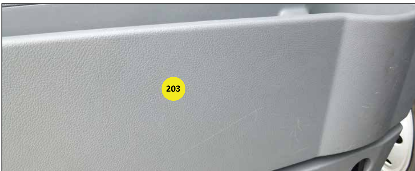
203 - Portier binnen is beschadigd onder bakje / links
